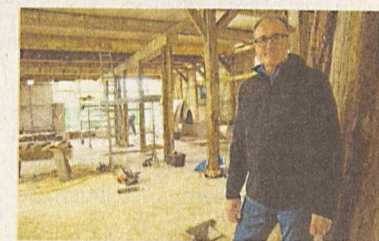
Jörg Ruschmeyer steht in der Scheune, die umgebaut wird.
