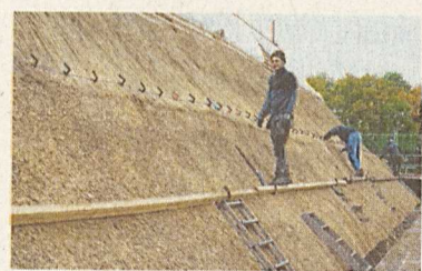
Die Scheune wird komplett mit einem neuen Reetdachgedeckt.
